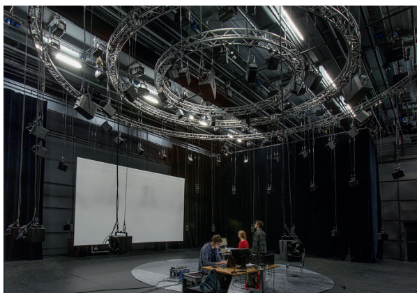
Le dispositif HOA installé dans la Grande salle du Centre Pompidou pour la pièce Pocket of Spaces de N. Barrett et The Open Ended Group.
